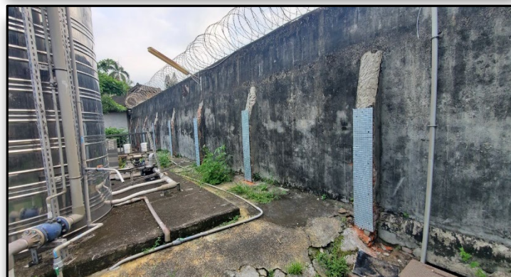
鋼板補強假固定
