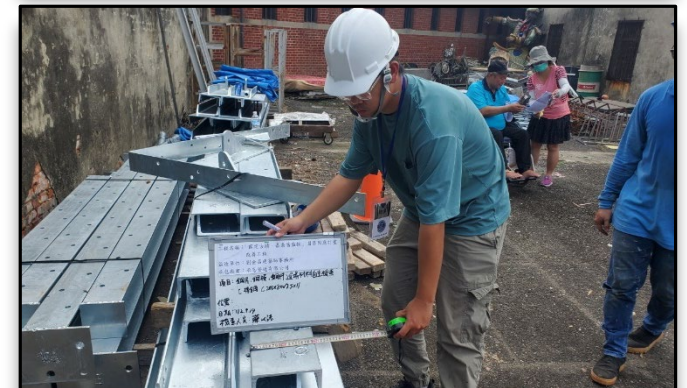
型鋼及鋼板進場
