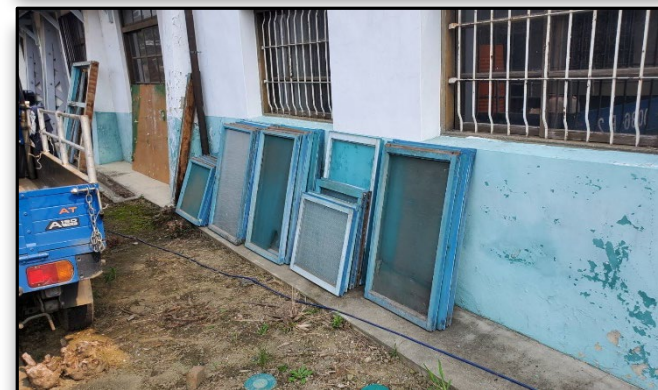
炊場木框拆除
