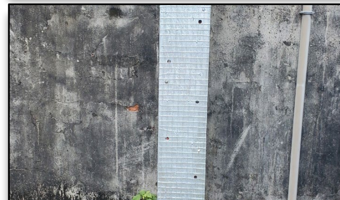
鋼板補強假固定
