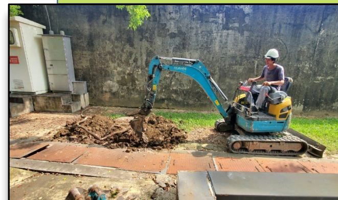
消防管溝開挖
