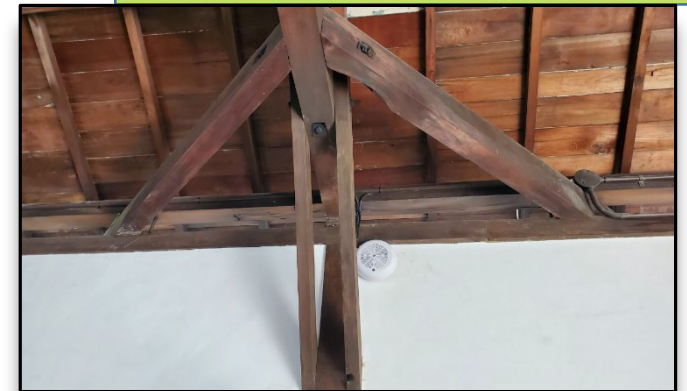
消防設備配管配線
