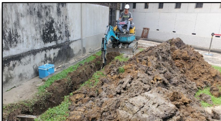
消防管溝開挖
