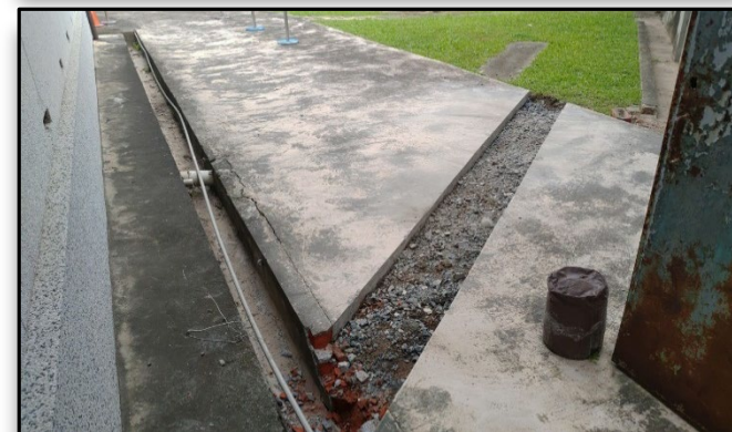
消防管溝開挖
