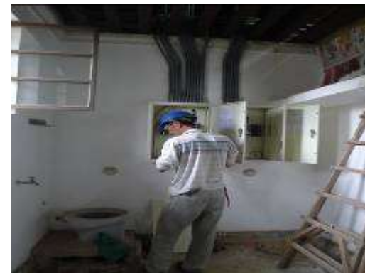
舍房電氣配線施作
