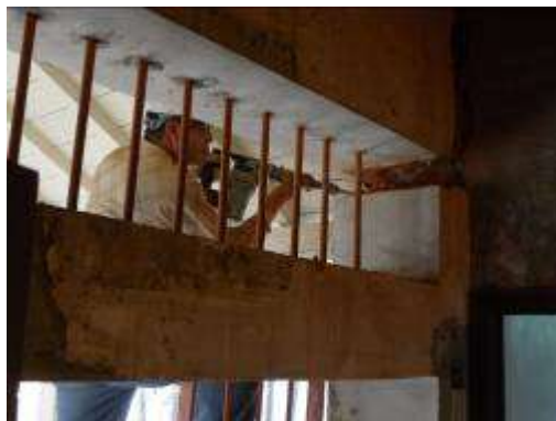
電氣配線施作
