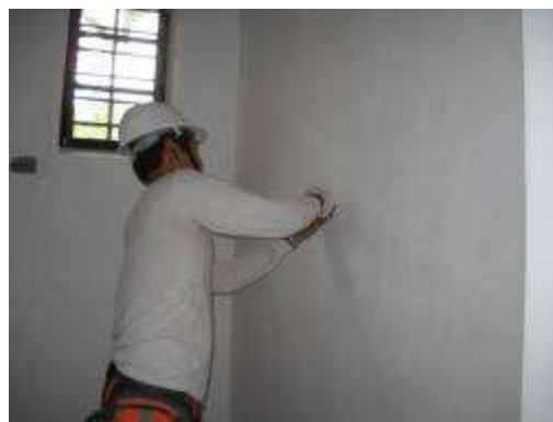
牆面白灰壁體施作
