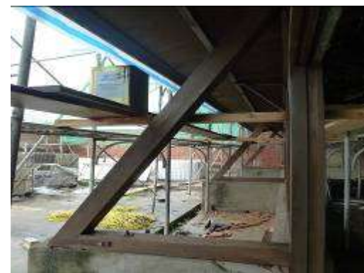
雨庇整修施作
