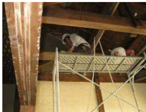
編竹夾泥牆施作
