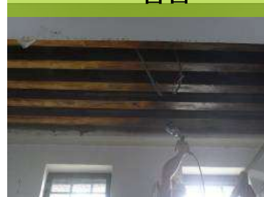
天花板護木油施作
