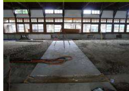
地坪鑿修施作
