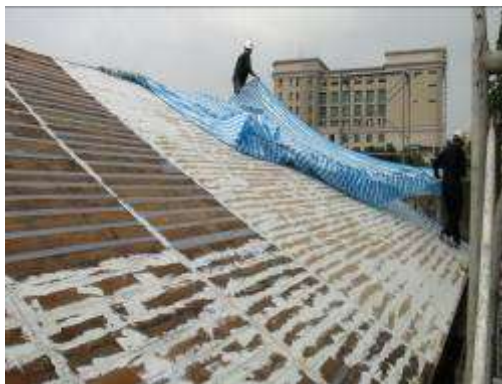
屋面板批土施作
