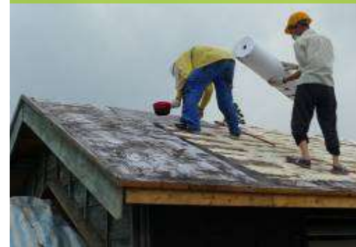
屋面防水層鋪設施作
