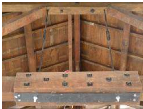
高拉力鋼棒施作
