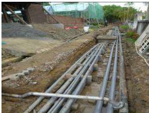
共同管溝開挖施作
