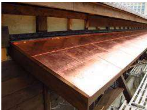
銅皮屋面安裝施作
