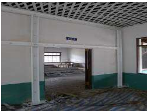
結構補強施作
