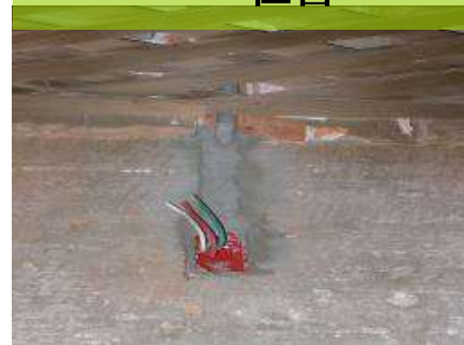
電氣配線施作
