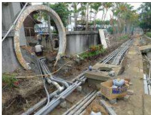
消防給水管施作
