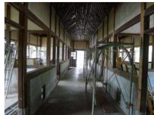
立柱修補施作
