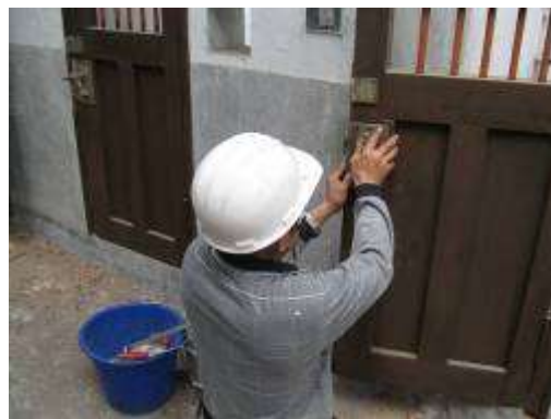
門框扇整修施作
