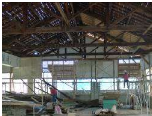
編竹夾泥牆整修施作
