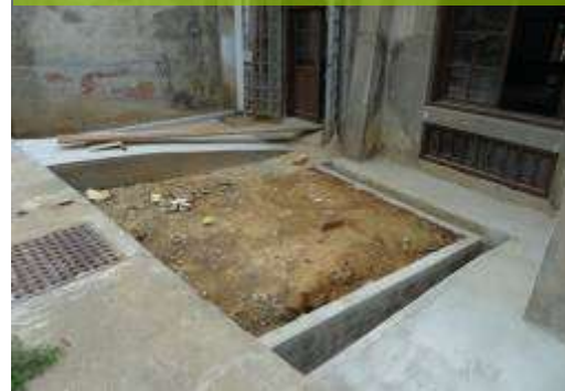
排水溝壁體整修施作
