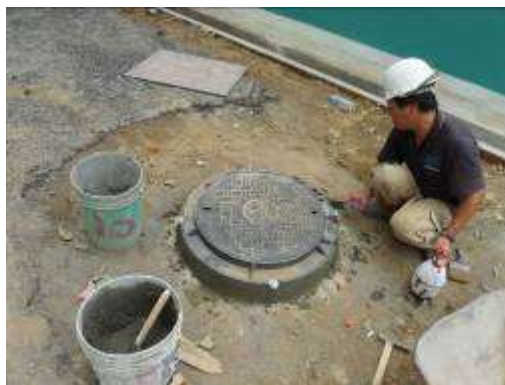
人孔蓋整修施作
