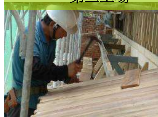
雨庇整修施作
