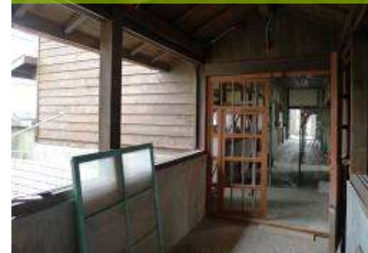
廊道電氣配線施作
