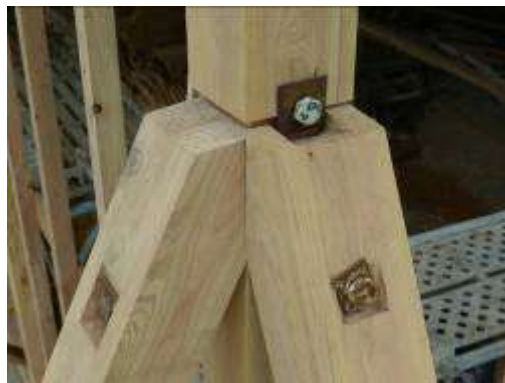
結構立柱整修施作
