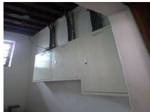
電氣開關箱安裝施作
