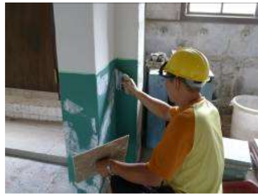
牆面油漆施作
