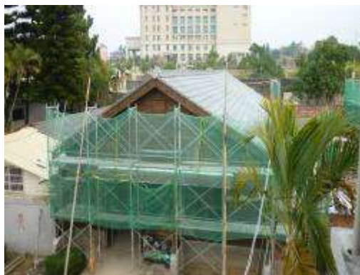
雨淋板整修仿作
