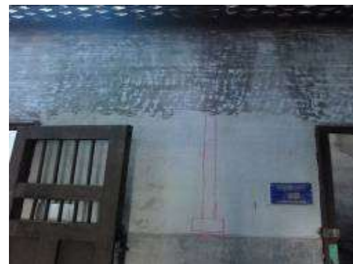
電源開關施作
