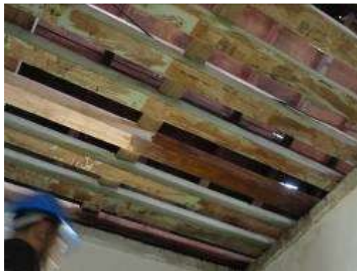
舍房天花板整修仿作
