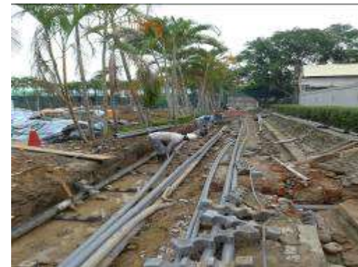
消防給水管施作
