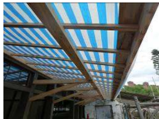
雨庇整修施作
