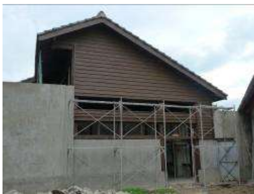
雨淋板整修施作
