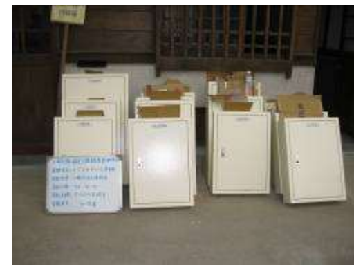
電氣開關箱進場
