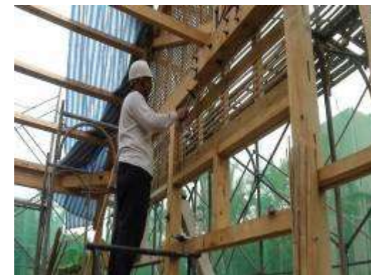
編竹夾泥牆施作
