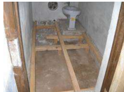
舍房木地板鋪設施作
