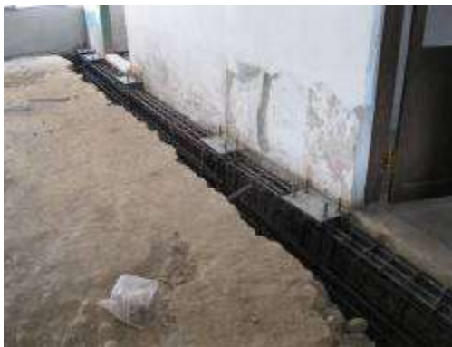
結構補強地樑施作
