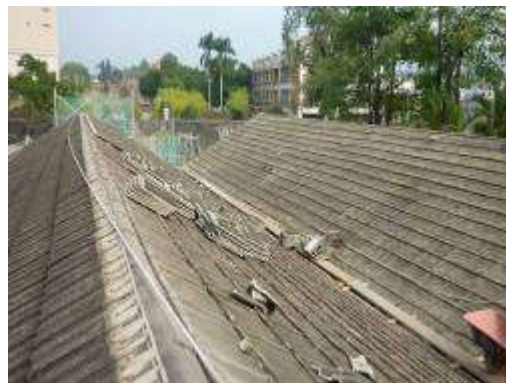
屋面水泥瓦拆除施作
