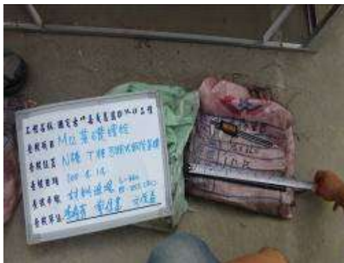
基礎螺栓進場
