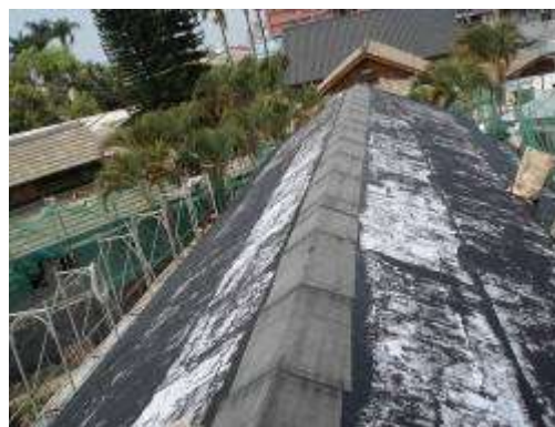
屋面防水層施作
