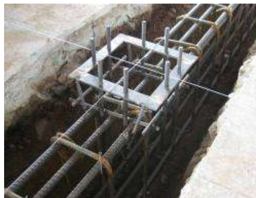
結構補強地樑施作
