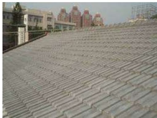
屋面水泥瓦鋪設施作
