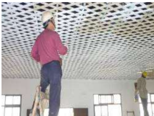
竿緣天花油漆施作
