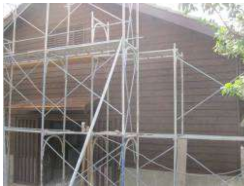
雨淋板整修仿作
