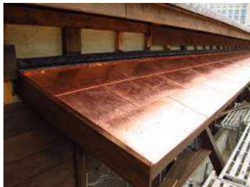
銅皮屋面安裝施作
