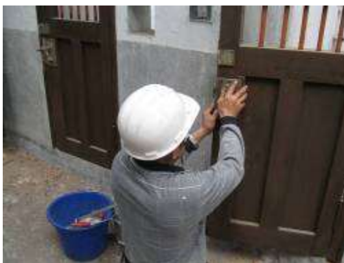
門框扇整修施作
