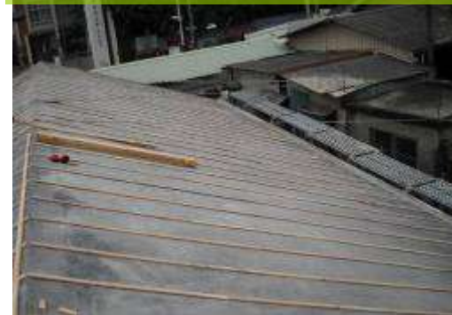
屋面掛瓦條施作
