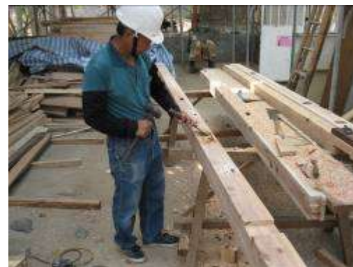
屋架桁木整修施作
