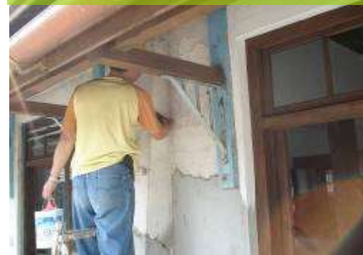
牆面壁體整修施作
