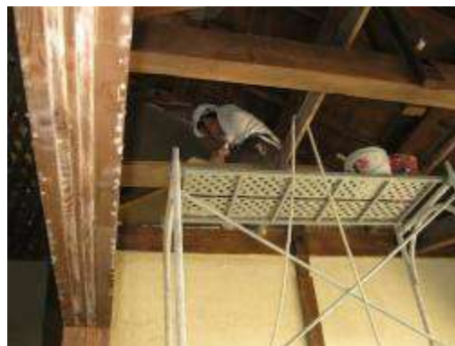
編竹夾泥牆施作
