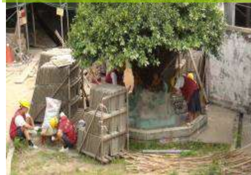
地景修繕施作
