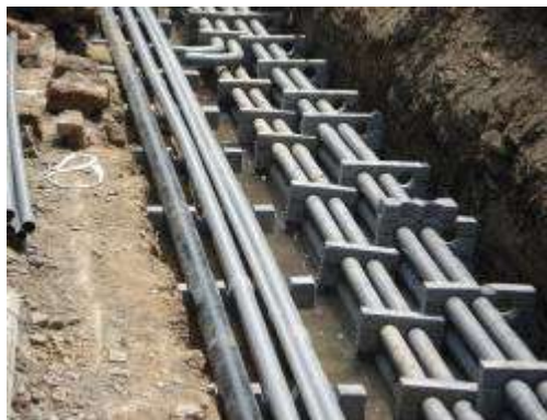
給水管線開挖施作
