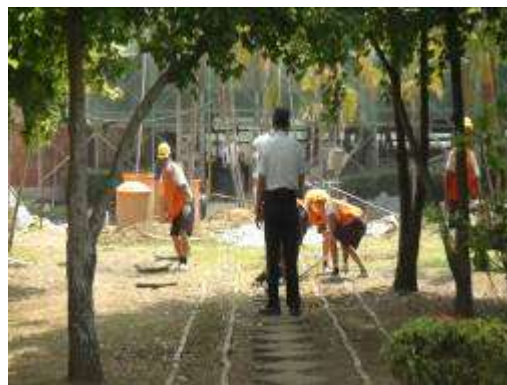
庭園鋪面地磚施作
