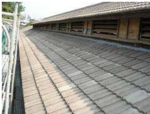
水泥瓦鋪設施作
