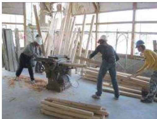
屋架椽條整修施作
