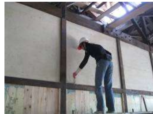
編竹夾泥牆壁體整修仿作
