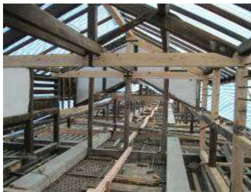
屋架桁木整修仿作
