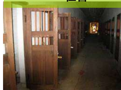
門板護木油施作
