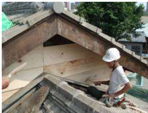
雨淋板整修仿作
