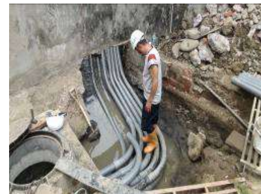
給水管路施作
