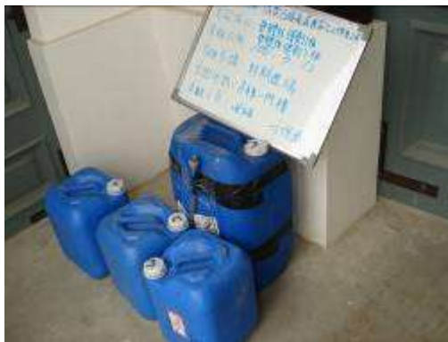
壁體防水材料進場
