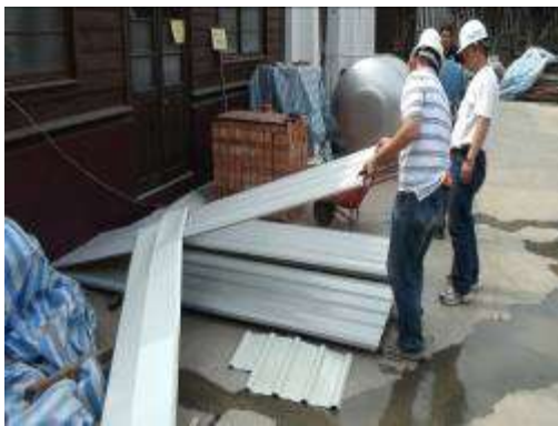
屋面鋼浪板進場
