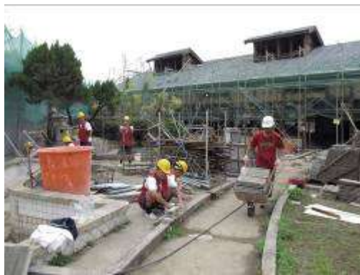
地景造型修繕施作
