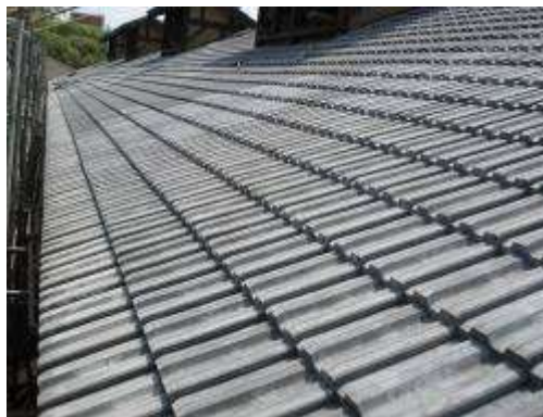
屋面水泥瓦鋪設施作
