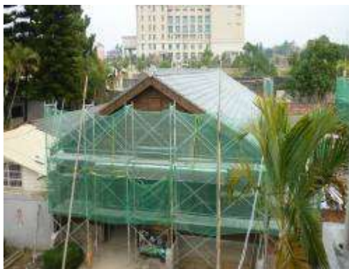
雨淋板整修仿作
