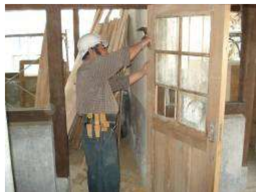
門板整修仿作
