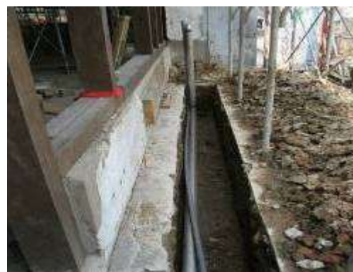
消防給水管施作
