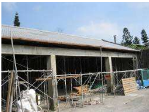
銅製天溝安裝施作
