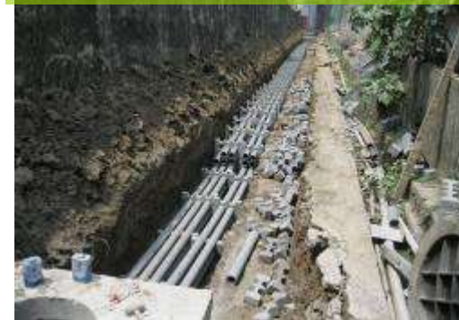
共同管溝開挖施作
