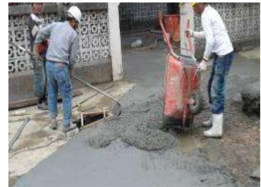
管溝混凝土回填澆置
