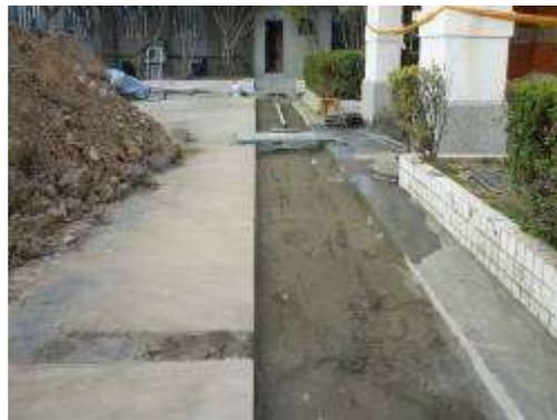
管溝鋪設回填施作
