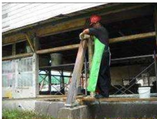
門窗剝漆施作
