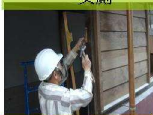
門板安裝施作
