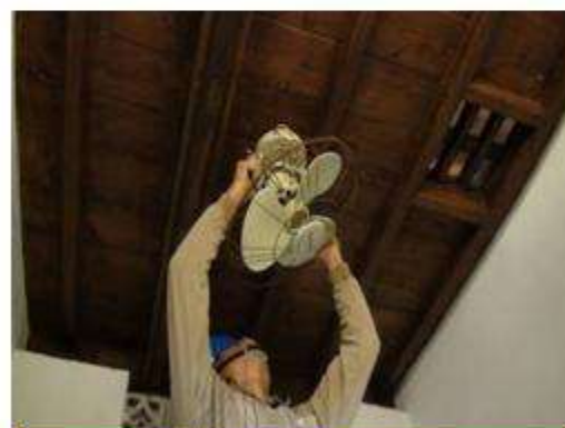
天花板電扇施作
