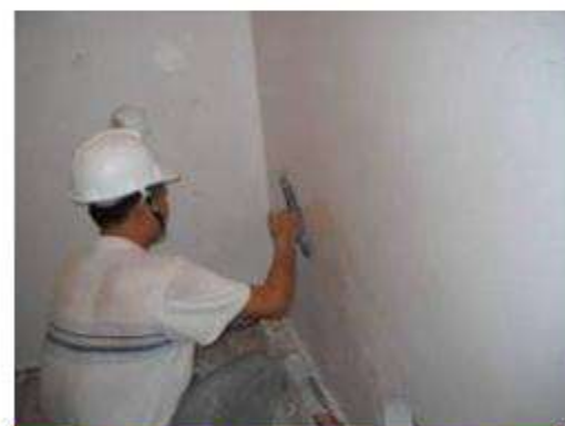
漆食壁壁體粉刷層施作
