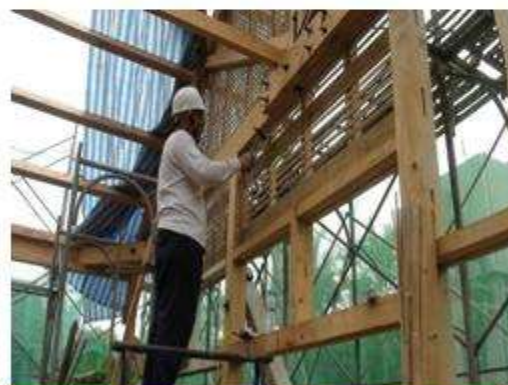
編竹夾泥牆施作
