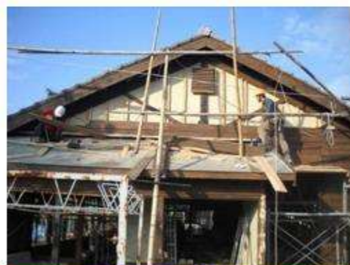
雨淋板整修仿作
