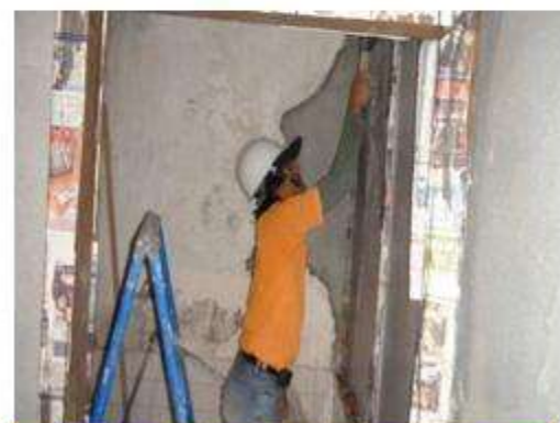
職員休息室牆面整修仿作
