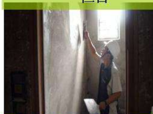
漆食壁壁體粉刷層施作
