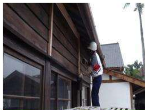
雨淋板護木油施作
