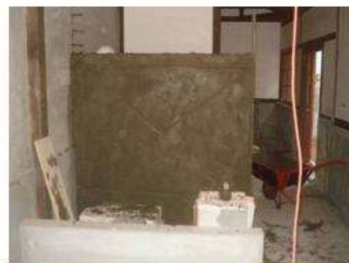
無障礙廁所牆面施作
