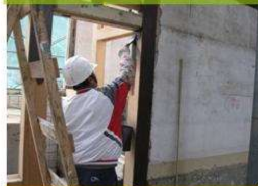
護木油塗刷施作
