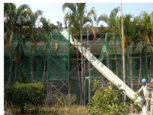
舍房屋瓦拆卸
