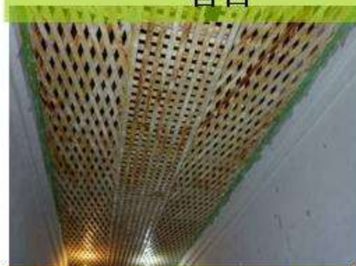
舍房天花板剝漆施作
