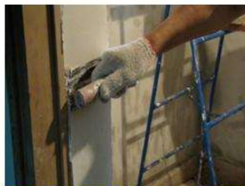
舍房白灰壁體粉刷層施作
