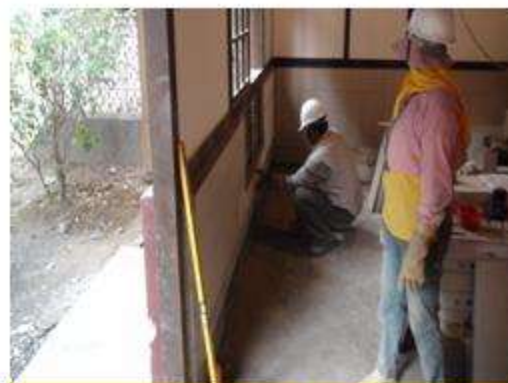
壁面磁磚施作
