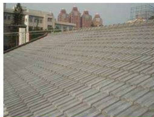
屋面水泥瓦鋪設施作
