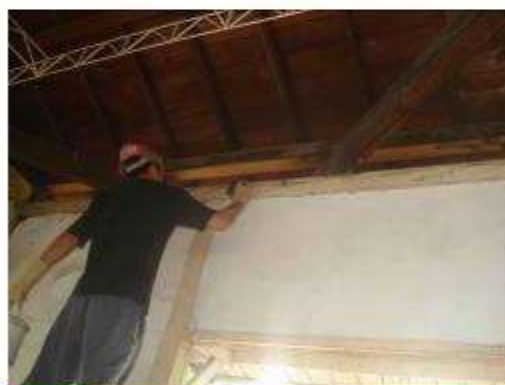
門窗剝漆施作
