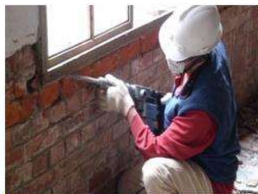
壁體整修新作
