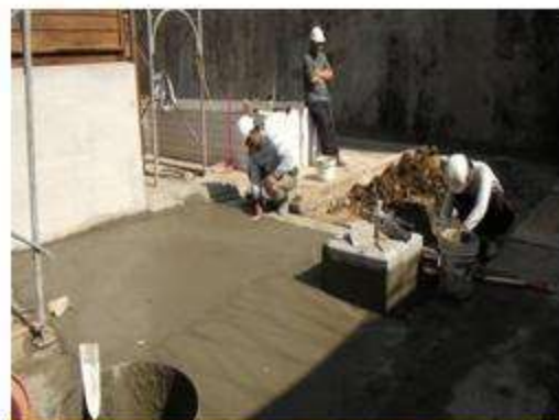
地坪粉光整修仿作
