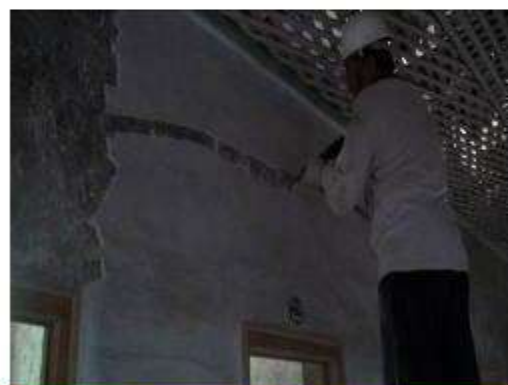
舍房壁體鑿修施作
