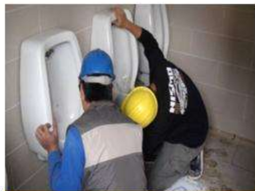
男廁小便斗安裝施作
