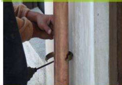
銅製落水管安裝施作
