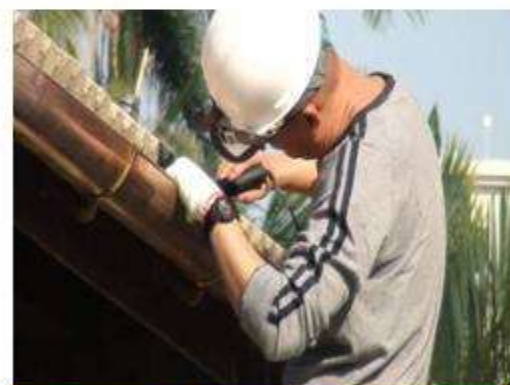
銅製天溝施作
