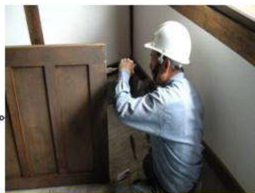
門窗整修施作
