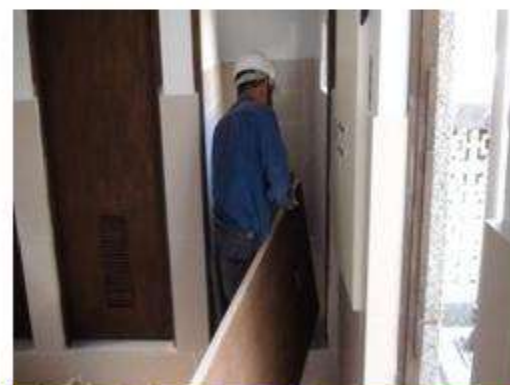
男廁門板安裝施作
