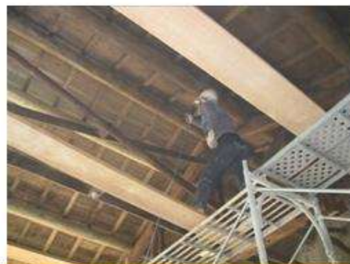
護木油塗刷施作
