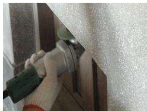
牆面磨石子施作
