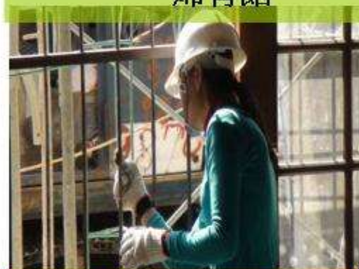
鐵窗防鏽漆施作
