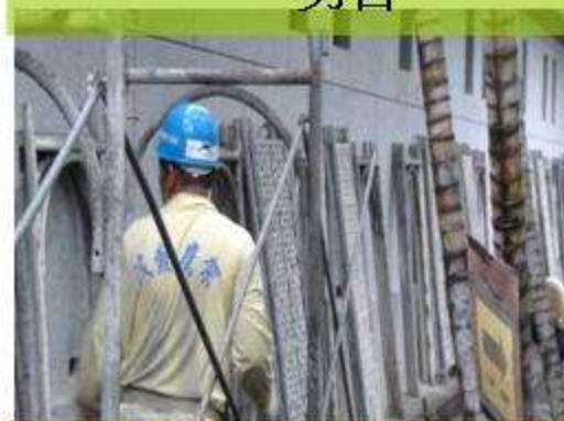
舍房外週鷹架組立
