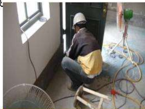
洗石子踢角研磨施作
