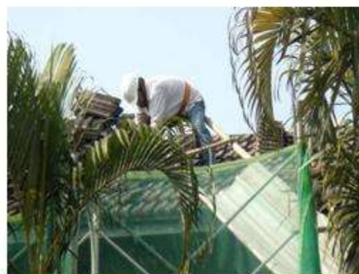
舍房屋瓦拆卸
