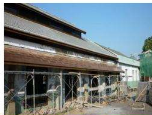
銅皮屋面施作
