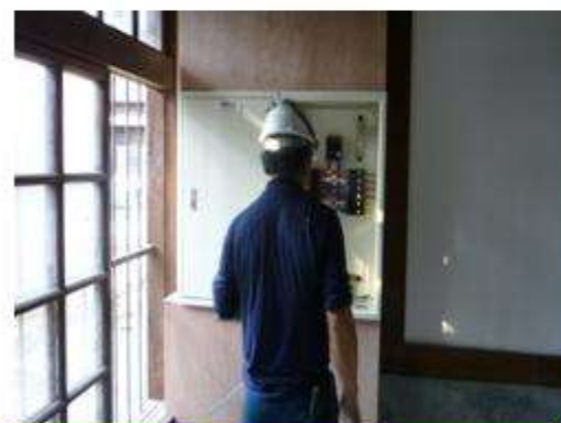
電氣管路施作
