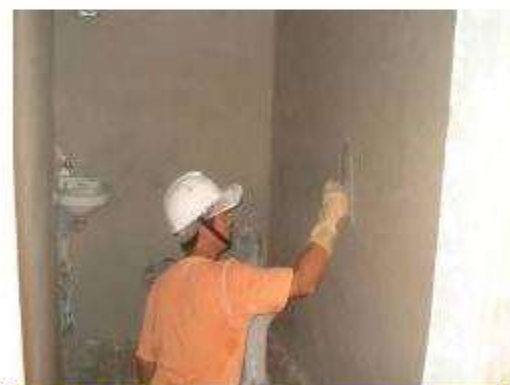
舍房白灰壁體粉刷層施作
