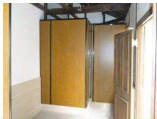
隔間磚牆砌磚施作
