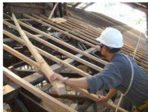
桁木椽條拆卸整修仿作
