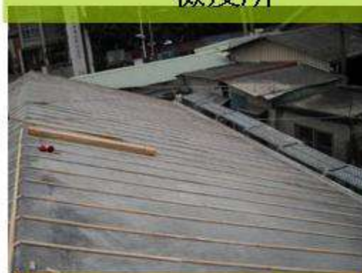
屋面掛瓦條施作
