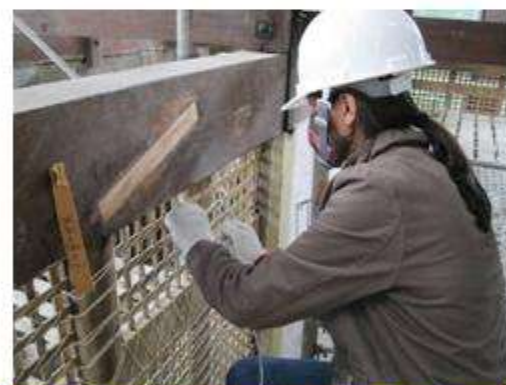
編竹夾泥牆壁體整修仿作
