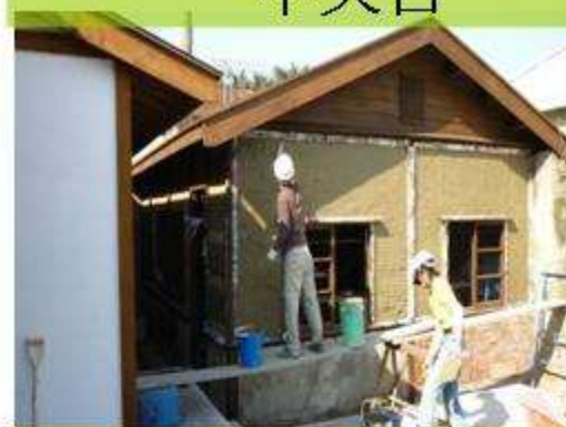
編竹夾泥牆施作
