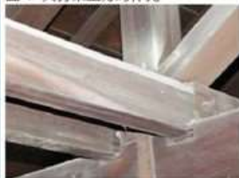
圖 5 視覺可及處，木料刨平，上方不易發覺處，則採用原木處理（位於智舍屋架）
