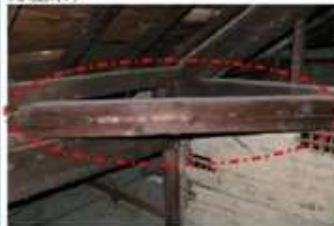
圖 3 火打梁上方的樑孔
