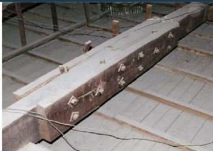
圖 13 材料不足時之樺接模式（行政辦公廳上方屋架）
