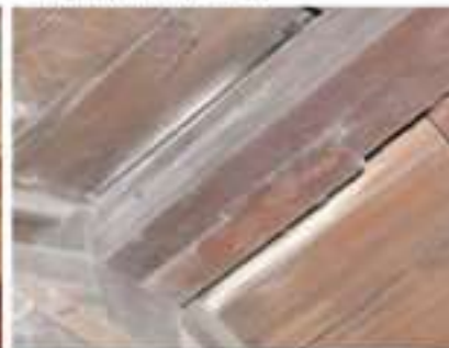
圖 11 材料不足時之傳統模式（智舍上方屋架）
