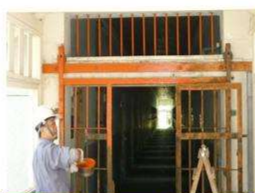
舍房鐵門紅丹漆施作
