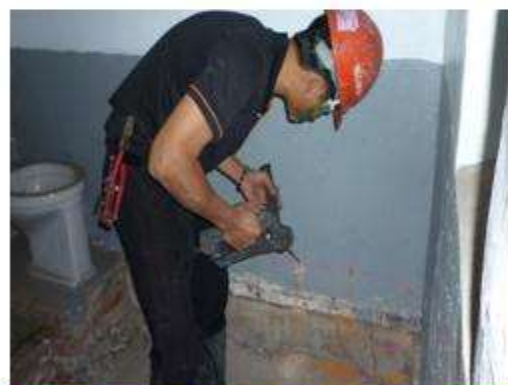
舍房牆面防潮灌注施作
