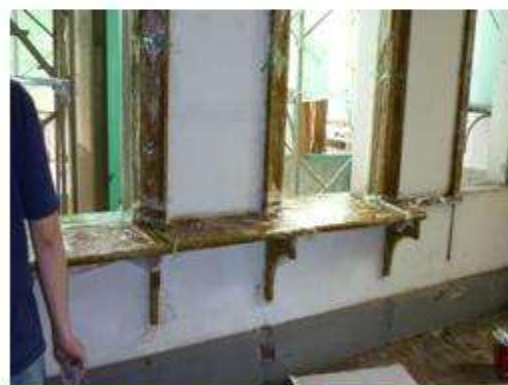
門窗剝漆施作
