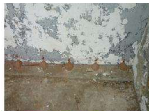
防潮灌注施作
