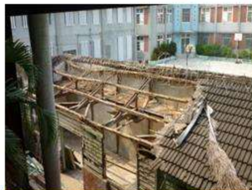
女廁屋面拆除
