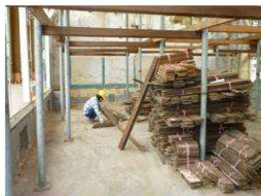
拆卸之木料整理
