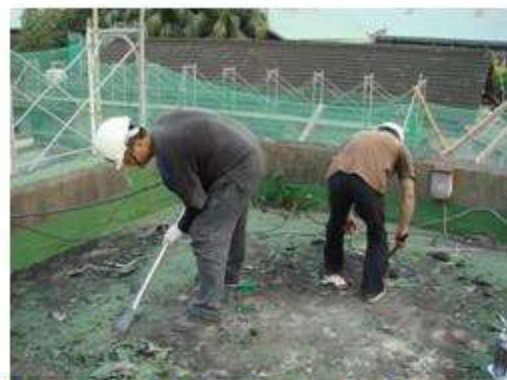
防水層剝除施作中
