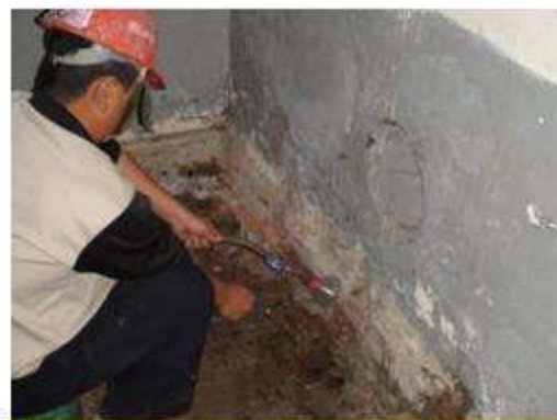
舍房牆面防潮施作
