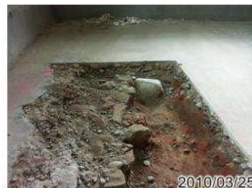
地坪地質試挖掘
