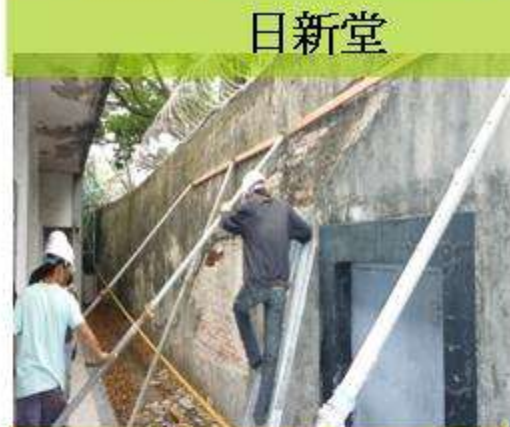
地震災損緊急加固
