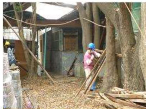
拆除之桁條整理
