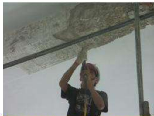
結構補強處粉刷層敲除
