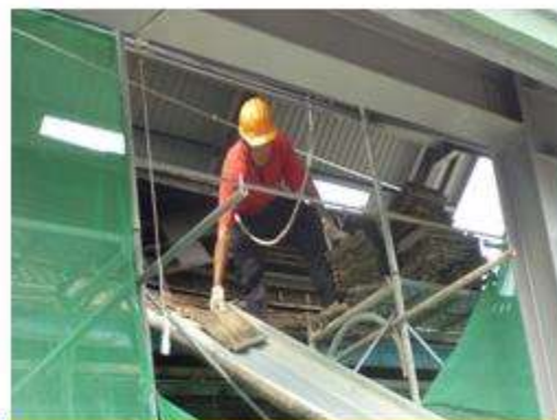
屋瓦拆卸施作中
