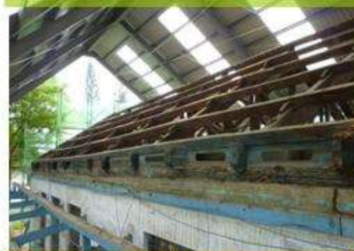
屋瓦拆卸施作中
