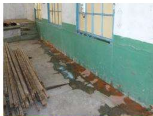
防潮灌注施作
