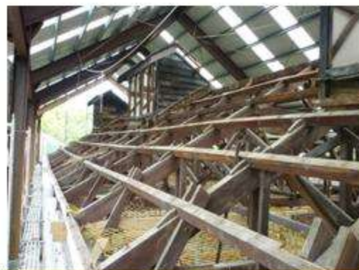
屋面板拆除後之現況
