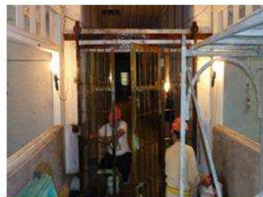
舍房鐵門剝漆施作
