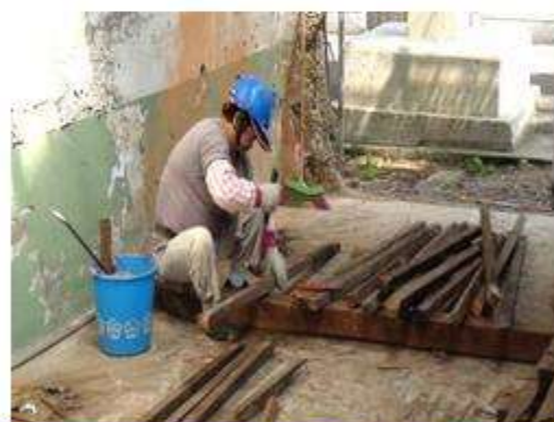
拆卸之木料整理
