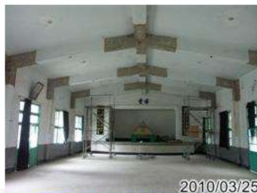
結構補強處粉刷層敲除
