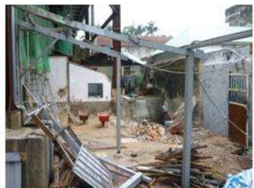
附屬建物拆除
