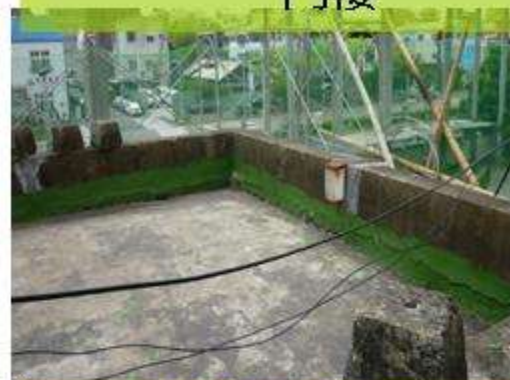
防水層剝除後
