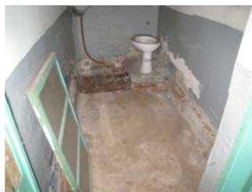
舍房地坪木地板拆除
