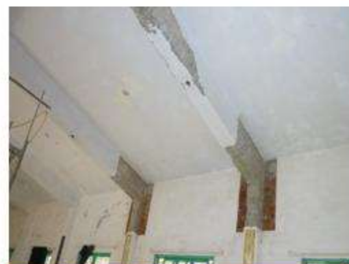
結構補強處粉刷層敲除
