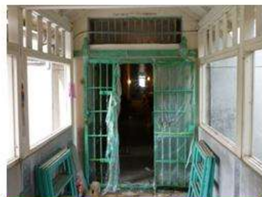
舍房鐵門剝漆施作
