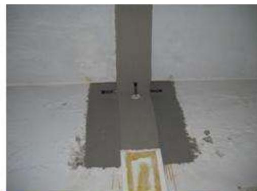
結構補強處裂縫灌注epoxy
