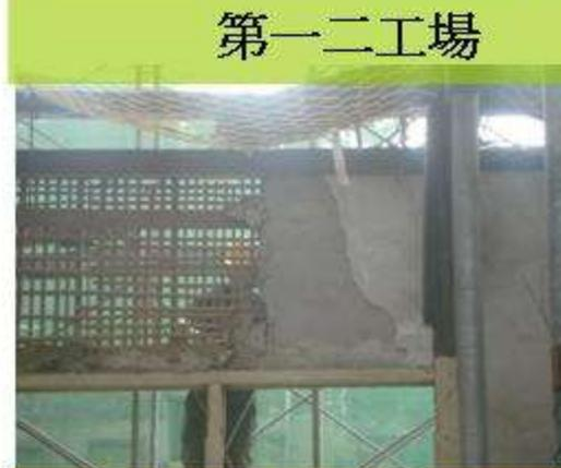
編竹夾泥牆浮凸拆除
