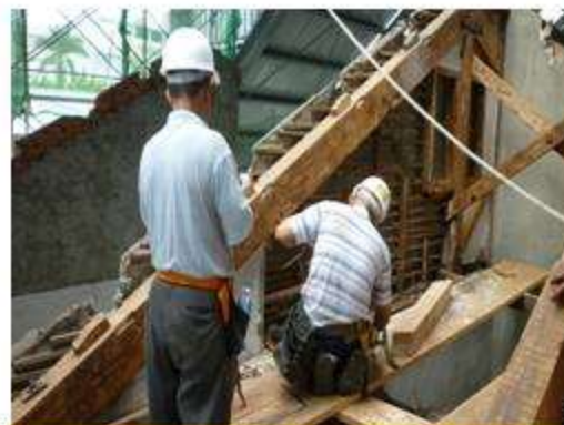
木構架拆卸整修、仿作
