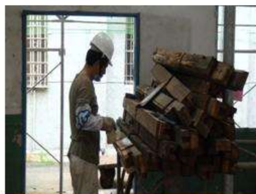
木構架拆卸整修、仿作
