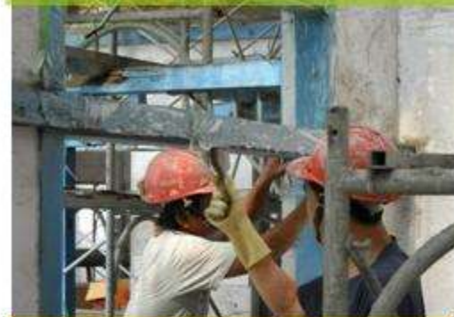
門窗剝漆施作
