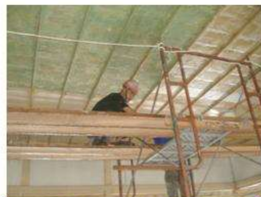
天花板剝漆施作
