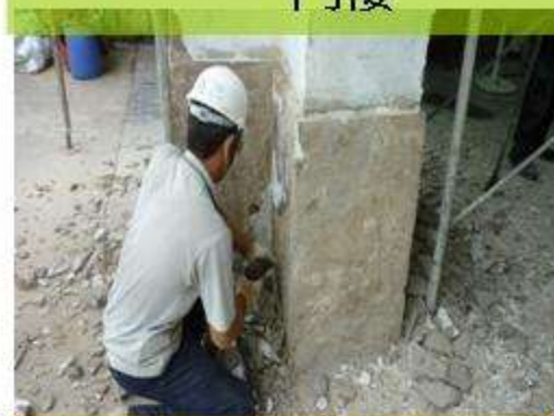
粉刷層浮凸敲除
