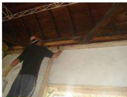
門窗剝漆施作
