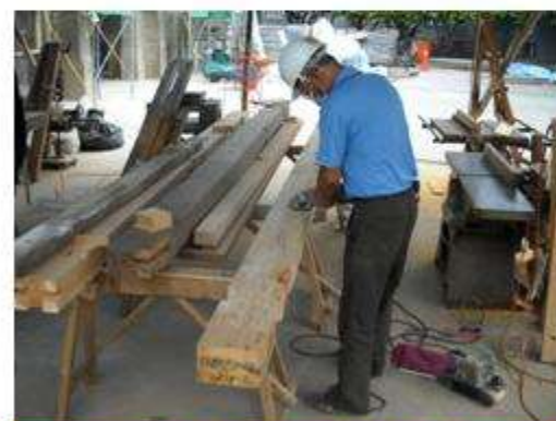
木構架拆卸整修仿作
