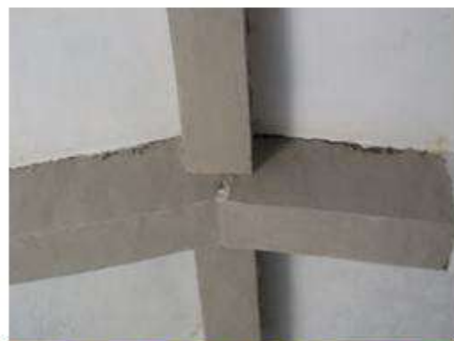
結構補強處無收縮水泥施作
