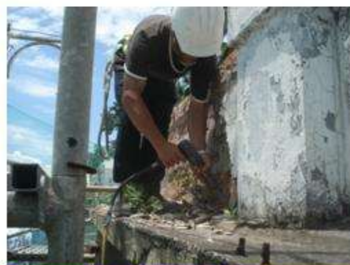
粉刷層浮凸敲除
