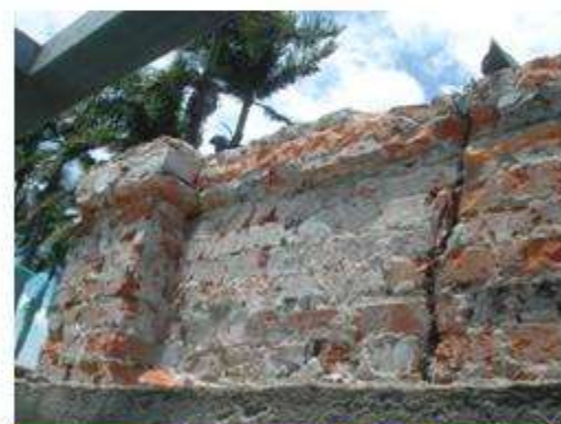
粉刷層浮凸敲除
