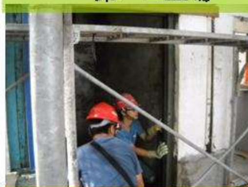
門窗剝漆施作
