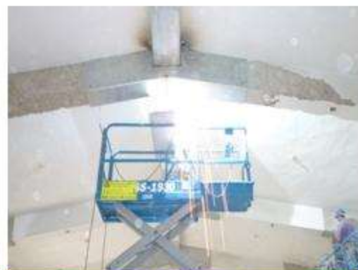
鋼板補強施作
