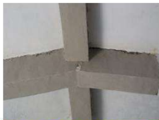
結構補強處無收縮水泥施作
