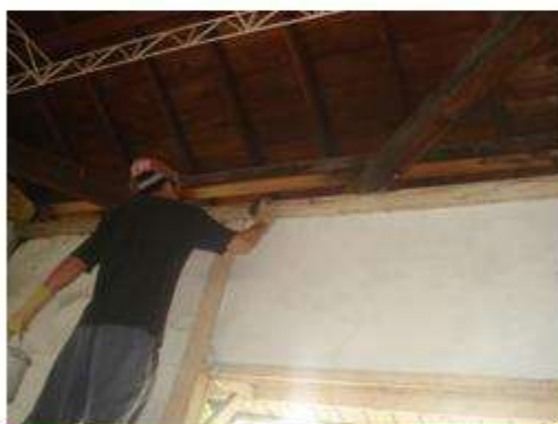
門窗剝漆施作
