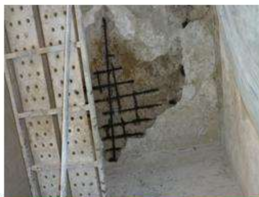
鋼筋防鏽處理
