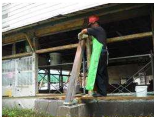
門窗剝漆施作
