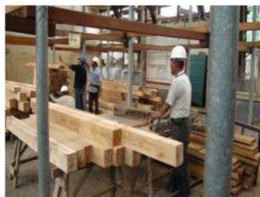
木構架拆卸整修仿作
