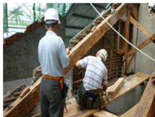
木構架拆卸整修、仿作
