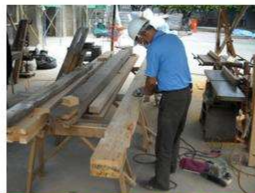
木構架拆卸整修仿作
