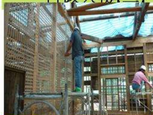
編竹夾泥牆施作
