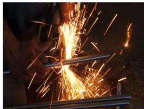
固定螺栓切割
