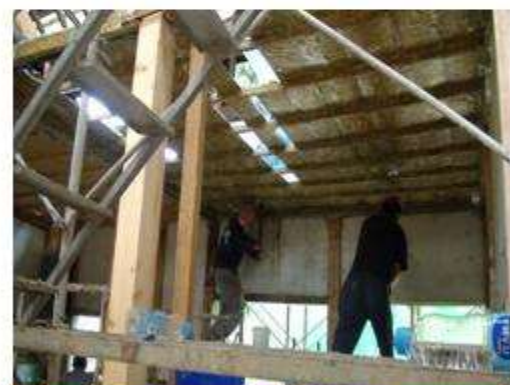
天花板剝漆施作
