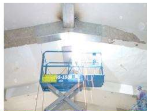
鋼板補強施作
