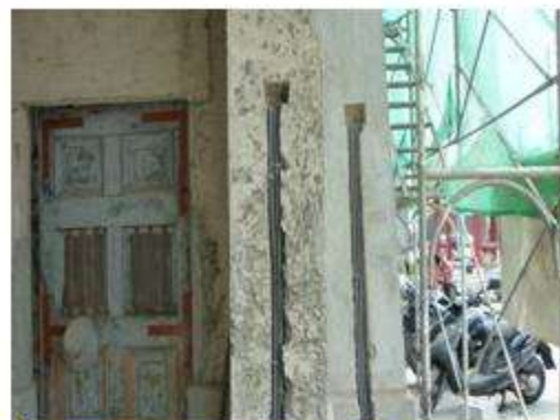
水電配管施作
