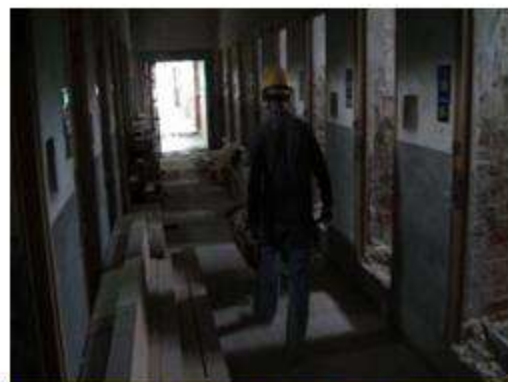
舍房壁體鑿修施作
