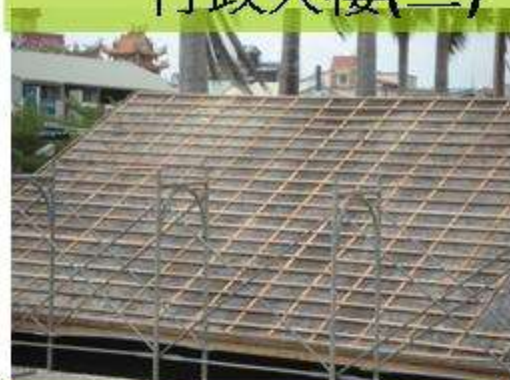
屋面掛瓦條施作
