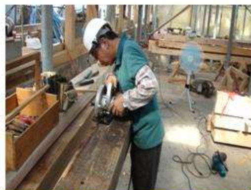
木構架拆卸整修仿作
