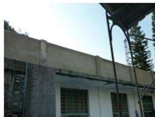
屋面高壓水柱清洗
