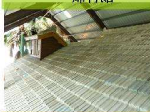
屋面水泥瓦施作
