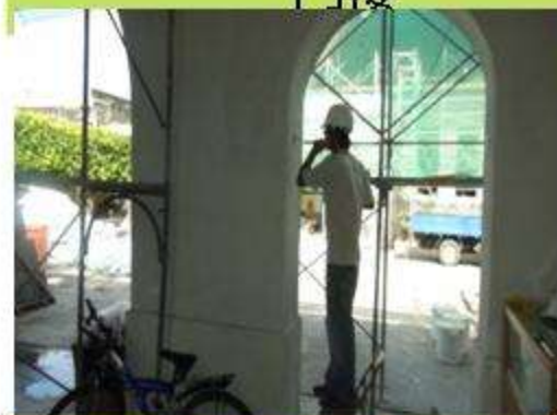
水電配管施作
