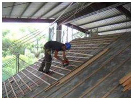
屋面掛瓦條施作
