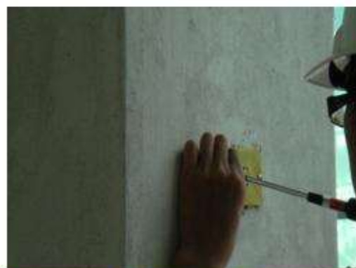
水電配管施作
