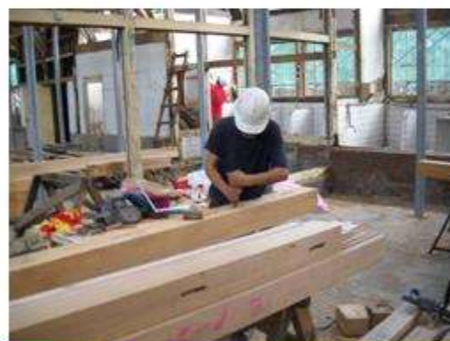
木構架拆卸整修仿作
