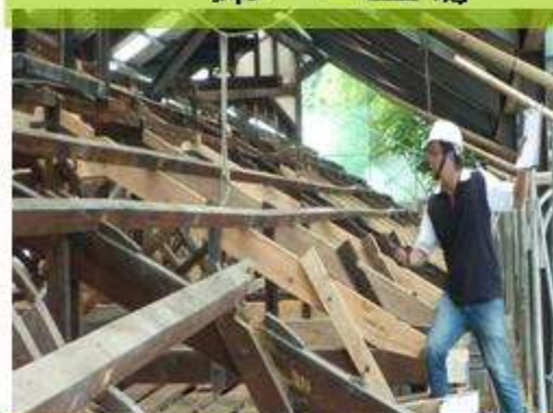
木構架拆卸整修仿作
