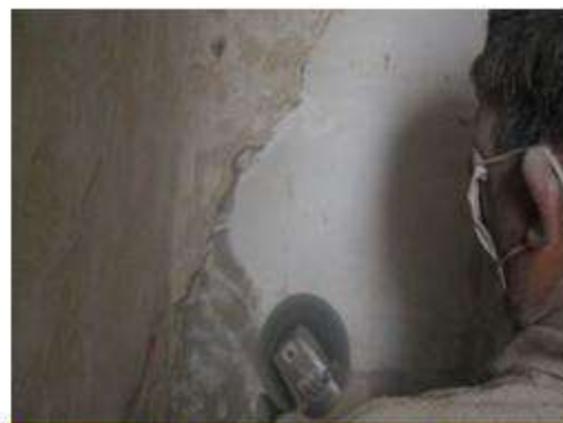
舍房壁體鑿修施作
