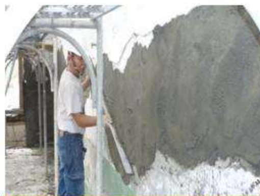
牆面粉刷層修補施作
