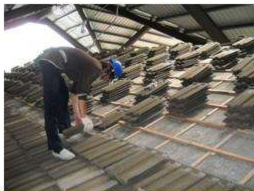
屋面水泥瓦施作
