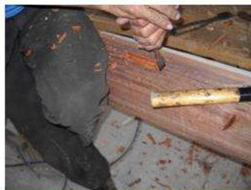
屋架整修仿作
