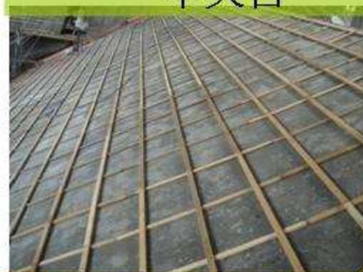
屋面掛瓦條施作
