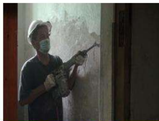
舍房壁體鑿修施作
