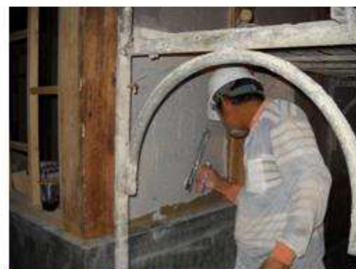
漆食壁壁體施作
