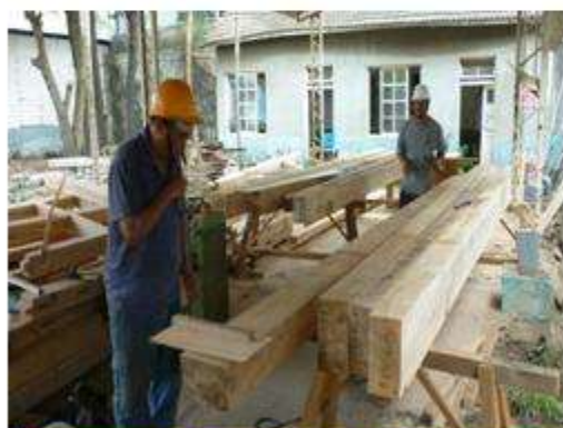
屋架整修仿作
