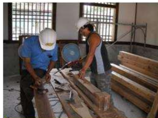
屋架整修仿作
