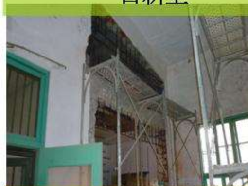
剪力牆植筋施作
