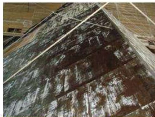
屋面防水層施作
