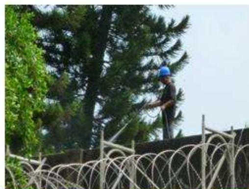
屋面高壓水柱清洗
