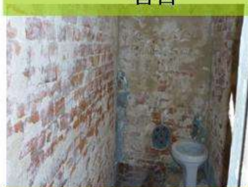
舍房壁體鑿修施作
