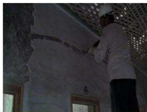
舍房壁體鑿修施作
