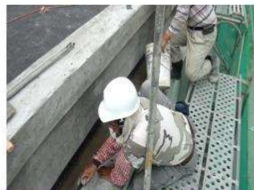
洩水溝槽施作
