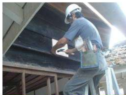
雨淋板修補施作
