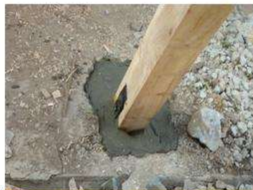
屋架扶柱整修仿作
