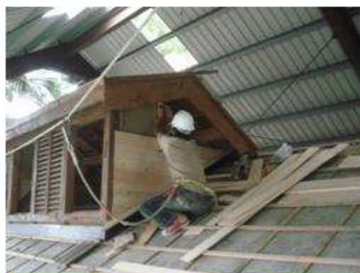
太子樓雨淋板施作
