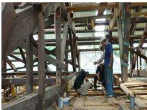
木構架拆卸整修仿作
