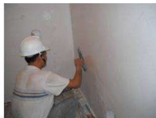
漆食壁壁體粉刷層施作
