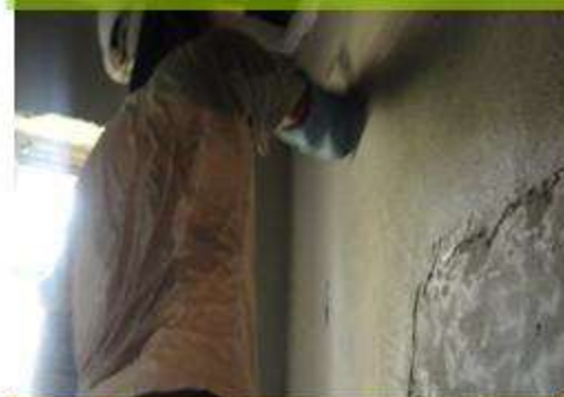
漆食壁壁體粉刷層施作
