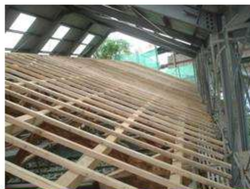
屋面桁木椽條施作
