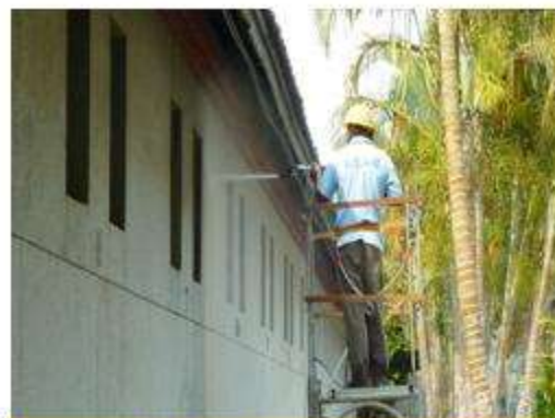
舍房外牆物理噴塗
