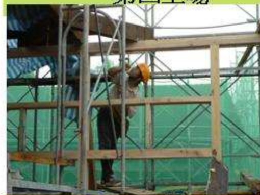
屋架整修仿作
