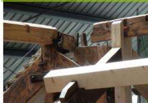
木構架拆卸整修、仿作
