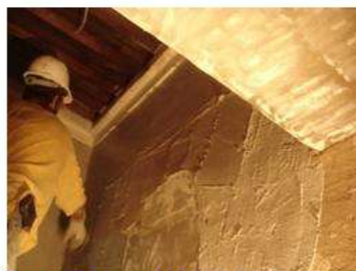
舍房白灰壁體粉刷層施作
