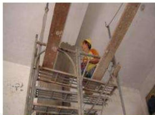
結構補強處油漆施作
