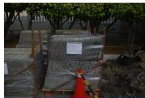
屋瓦堆置標示
