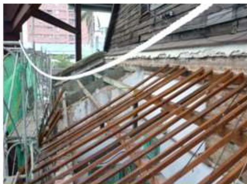
屋面板拆除後橡條拆除中
