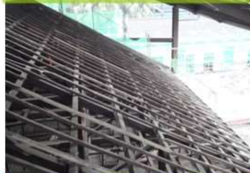
屋面板拆除後之現況
