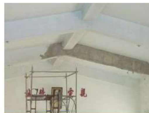
結構補強處粉刷層敲除
