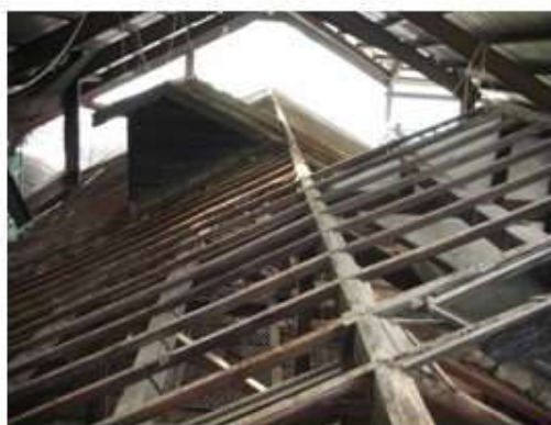
屋面板拆除後
