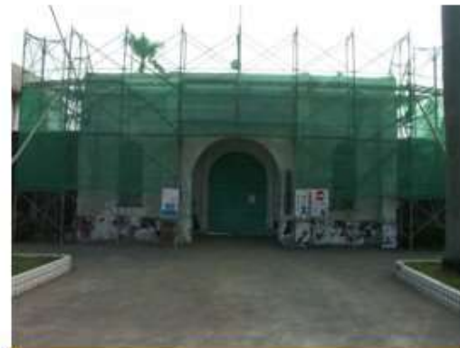
鷹架工程施作
