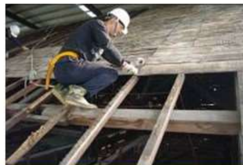
安全母索架設
