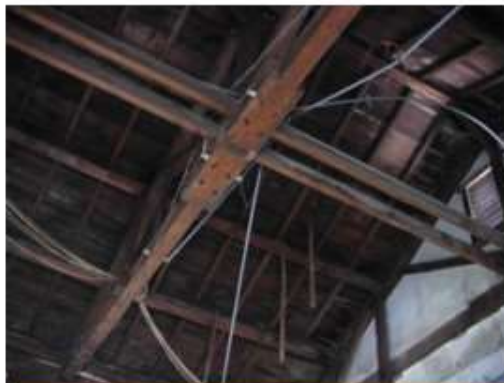
天花板拆除後之現況
