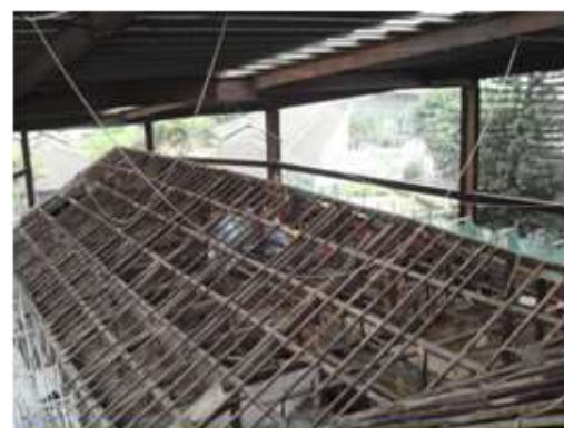
屋架拆除現況
