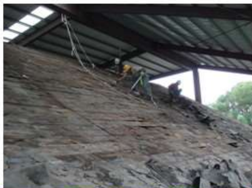
屋瓦拆除後防水層拆除中
