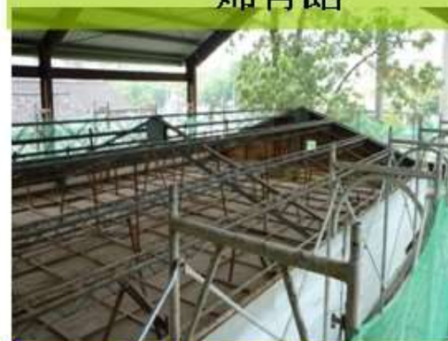
鐵皮屋瓦拆除後
