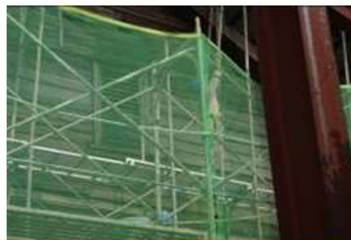
施工架防塵網
