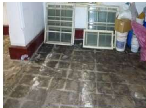
地毯及塑膠地板拆除後之現況
