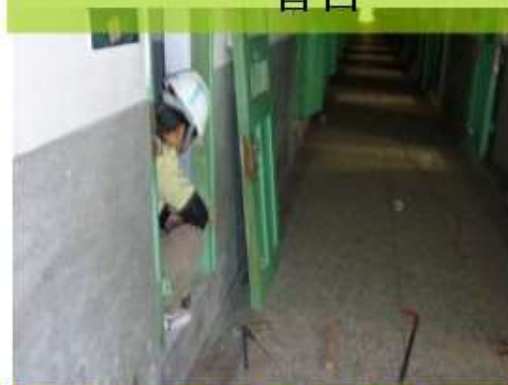
舍房門窗拆除之現況
