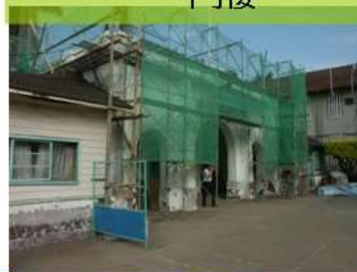
鷹架工程施作
