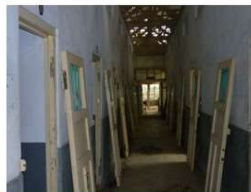
舍房門窗拆除之現況
