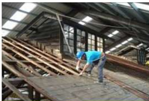
安全母索架設
