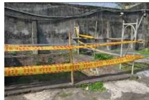
開口端設置警示
