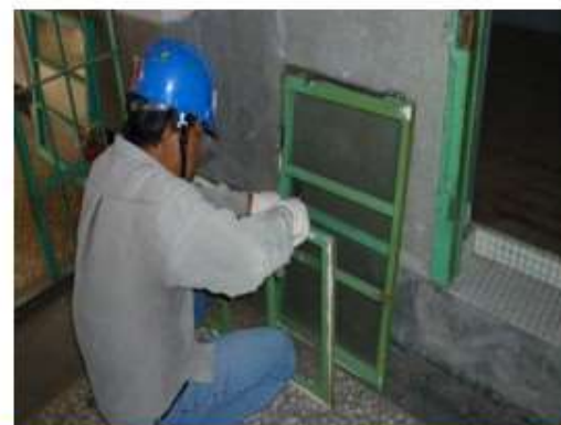
舍房門窗拆除之現況
