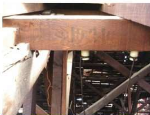
屋架構件材料尺寸標註
