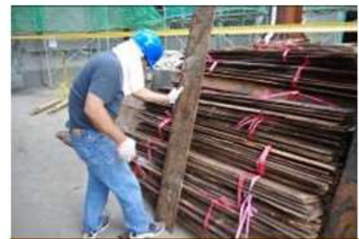
木襯板堆置標示
